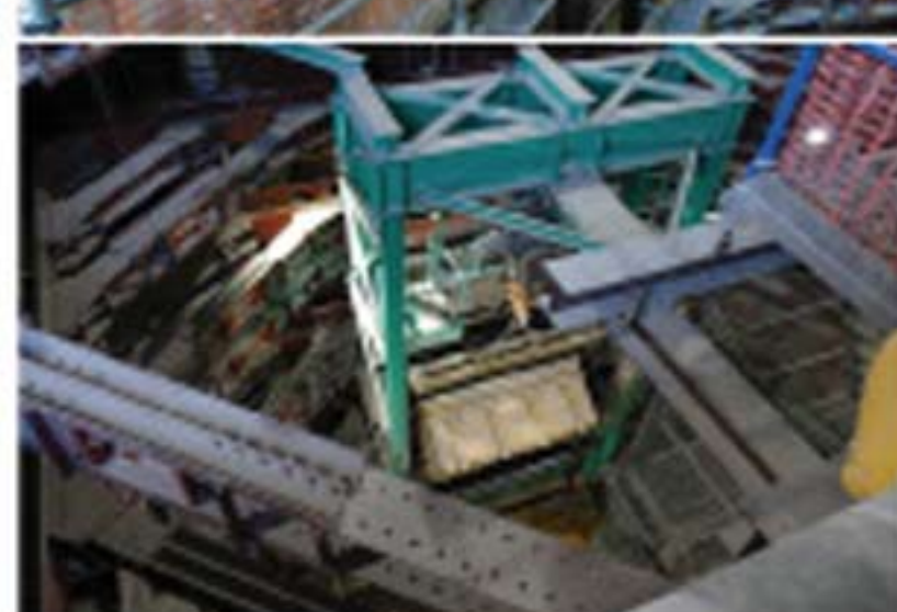
③掘削した土砂が発進立坑内に搬出・圧送(下)するところを見学する学生(上)
