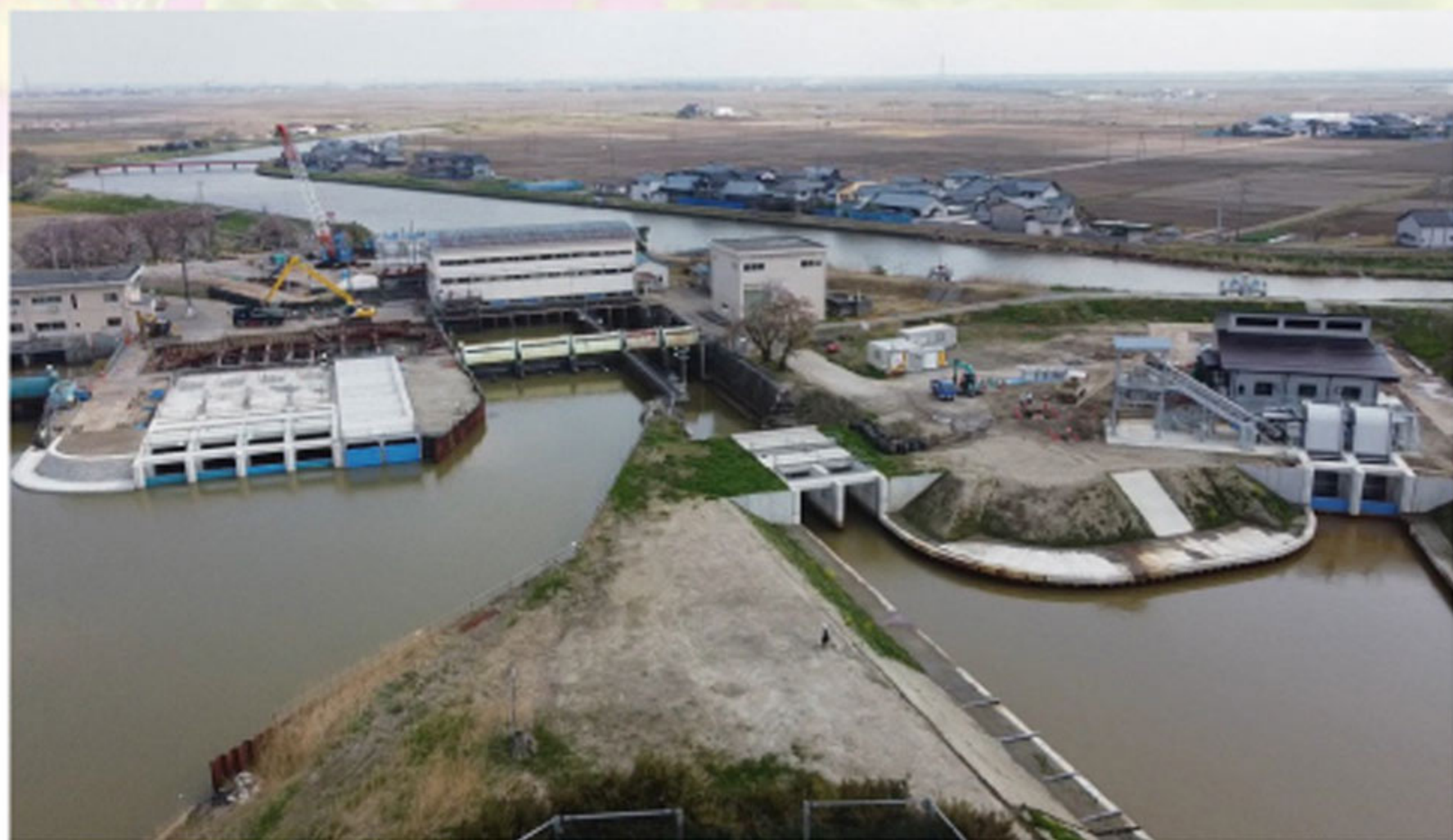
鑑潟排水機場 ※新潟県新潟市西蒲区
