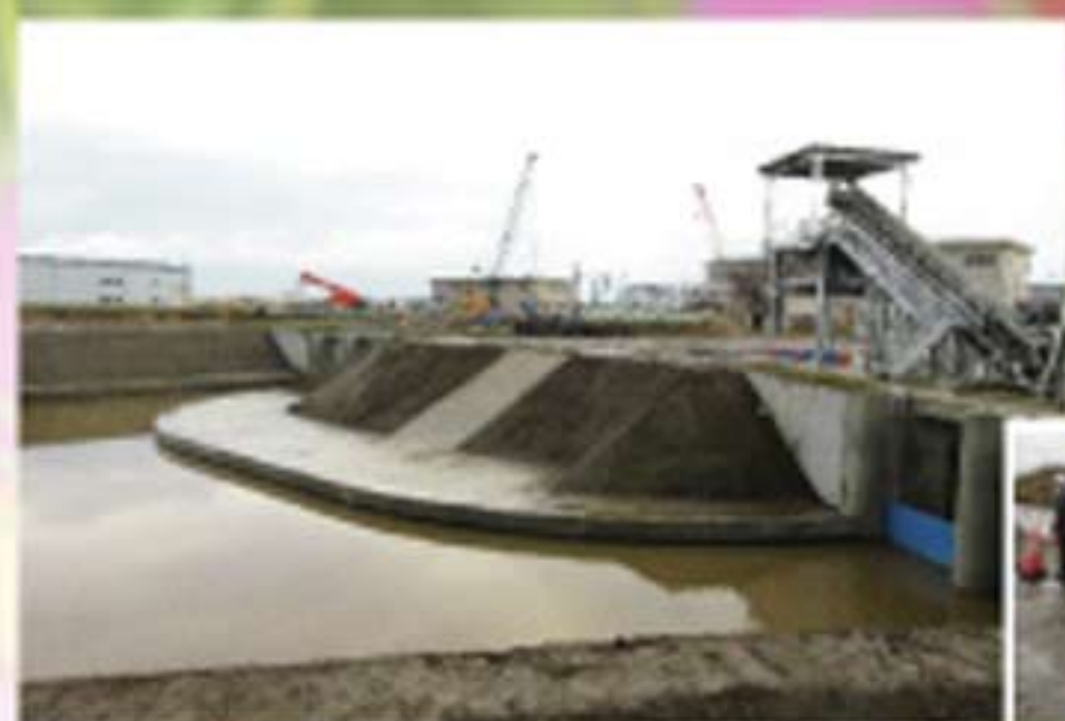
①釧路排水機場工事見学の様子
