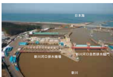
新川河口排水機場
