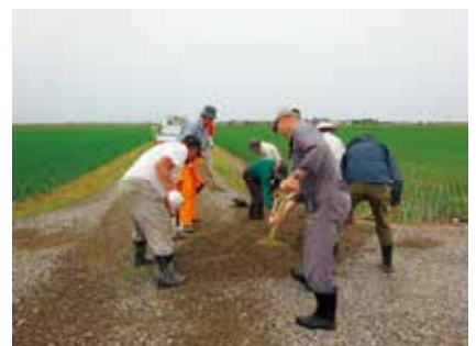
【写真10】 農道の補修 (写真提供：新潟市)
