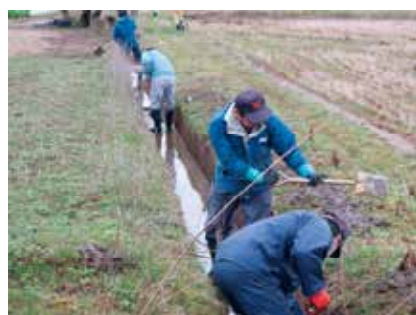
【写真9】 水路の土砂さらい (写真提供：新潟市)
