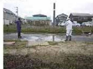
中間補給送水管 漏水(H22)による路面状況
