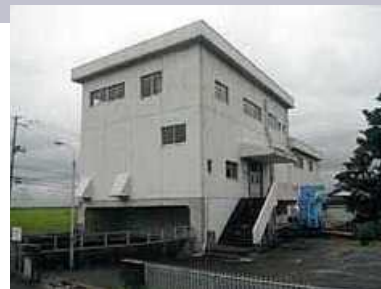
車場揚水機場
