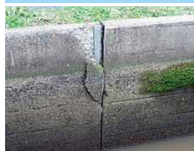
目地部分のコンクリート剥離 (左岸低位幹線用水路)
