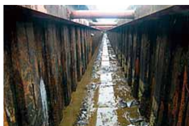
(2) の施工前(供用後26年経過)
