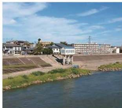
主要取水施設の小千谷頭首工
