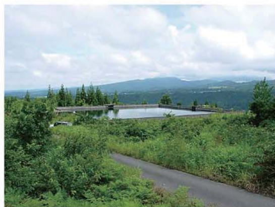
ファームポンド (城原ダムからの用水を一時的に貯留し、均等に圃場へ配水する)
