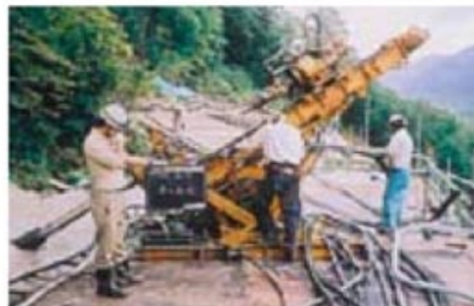
アンカー線挿入孔の削孔
