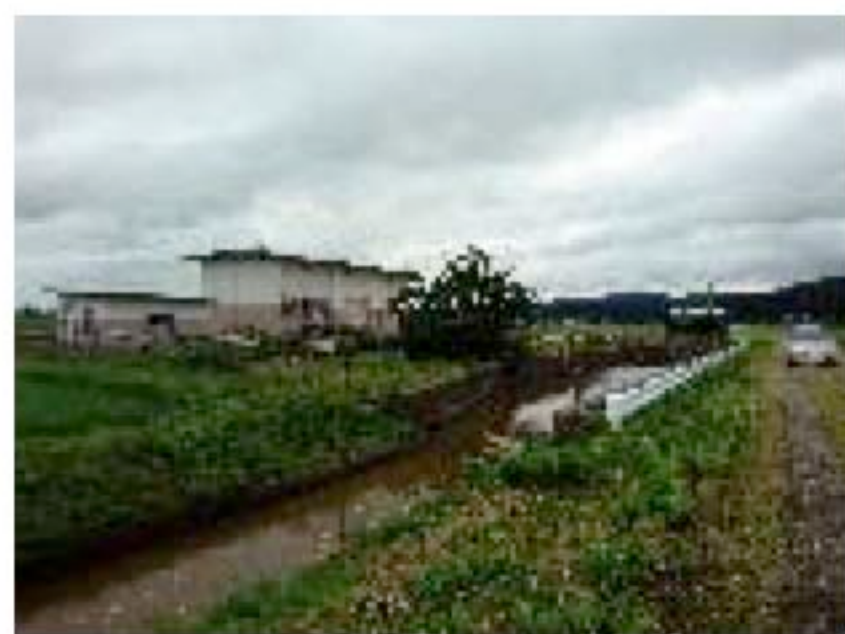
排水路から取水している 加圧機場
