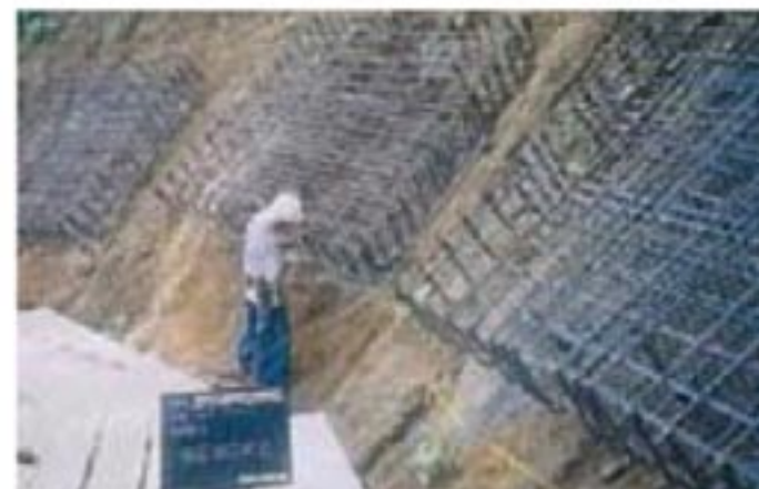
受圧板の製作
