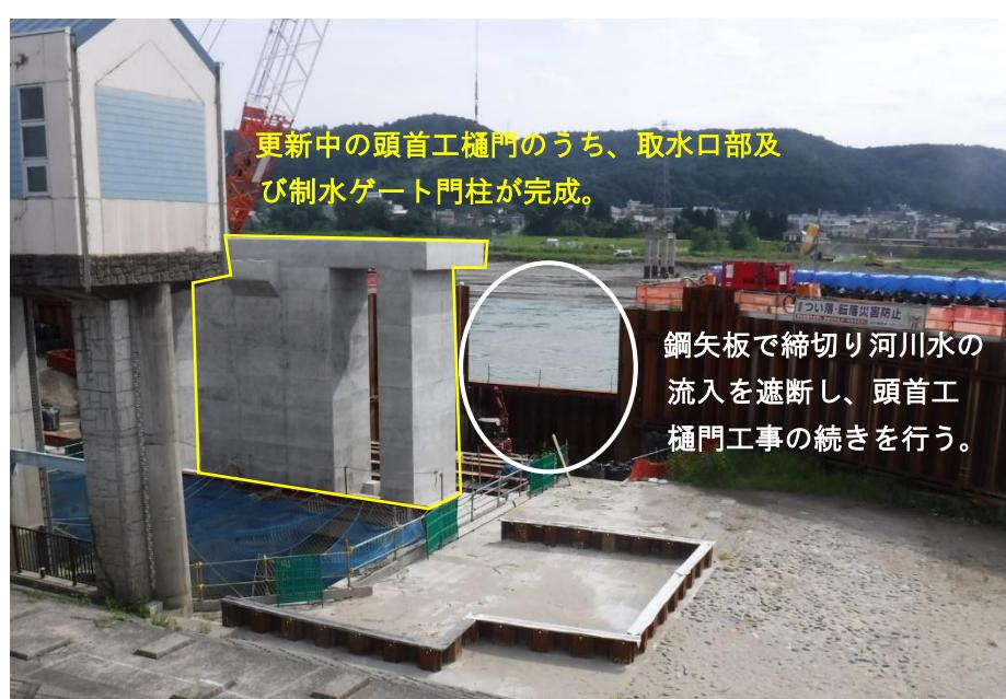
更新中の頭首工樋門のうち、取水口部及び制水ゲート門柱が完成。
