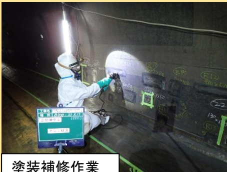
塗装補修作業
