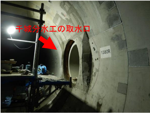
図6 千城分土工の取水口
