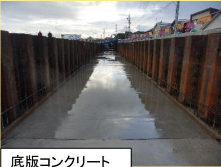
底版コンクリート
