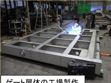
ゲート扉体の工場製作
