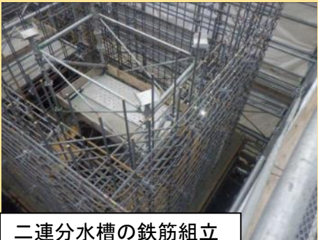
二連分水槽の鉄筋組立
