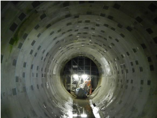
図4 新1号トンネル終点部
