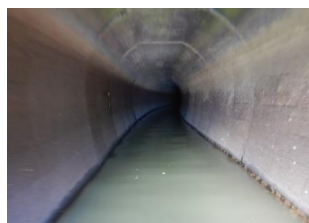
トンネル内の状況
