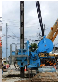
■サイレントパイラー
