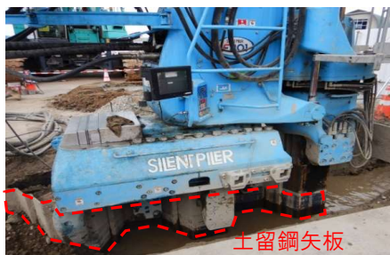
■鋼矢板の打ち込み
