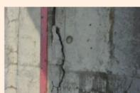
門柱のコンクリートのひび割れ
