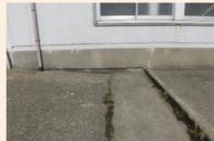
地盤沈下による亀裂
