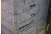
埋柱コンクリートの剥離
