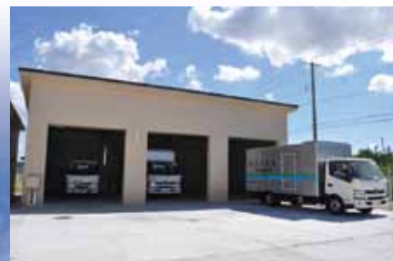
▲新川河口排水機場隣接地に整備された 移動式発電機車庫に格納されている 移動式発電機(1号車:右、2号車:中央)と 燃料輸送用のタンクローリー(左)
