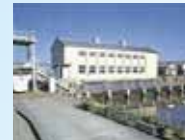
新川右岸排水機場全景
