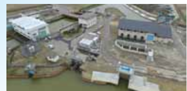
旧木山川排水機場の更新
