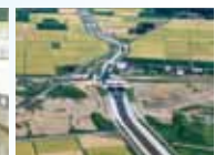
大通川放水路分土工
