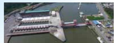
新川河口排水機場の更新
