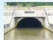
新々樋曾山隧道香口
