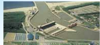
新川河口排水機場全景
