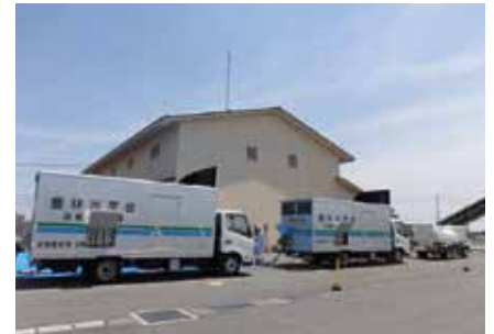
▲新川右岸排水機場における 予備電源の接続訓練
