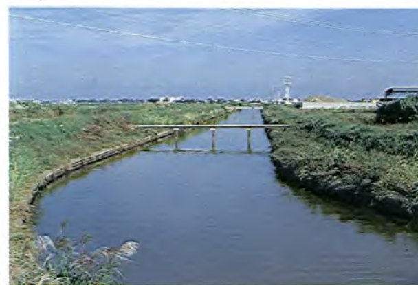
東部幹線排水路
