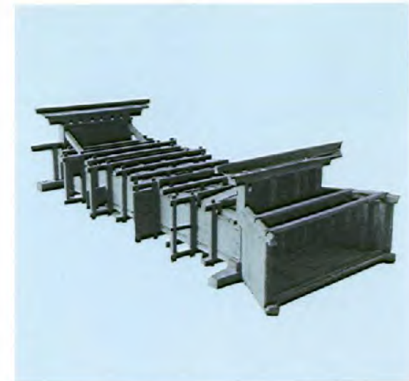
暗閘ができる前の「底樋」の模型
