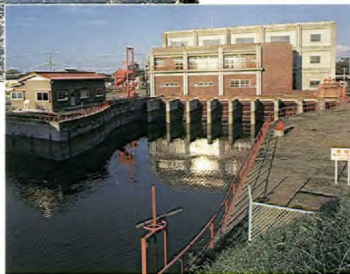
県営西川揚水機場 (渇水期補給用)
