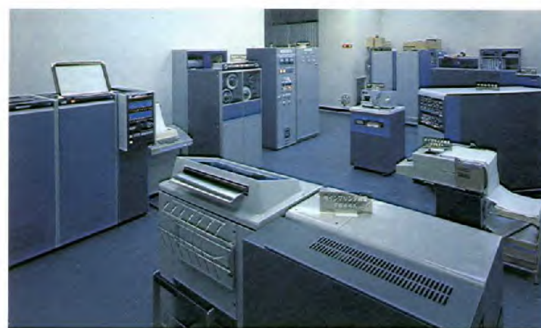
システムの心臓（コンピューター室）
