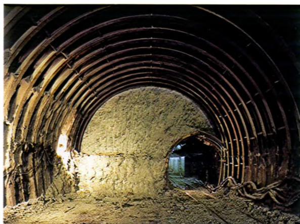
施工状況：覆工前
