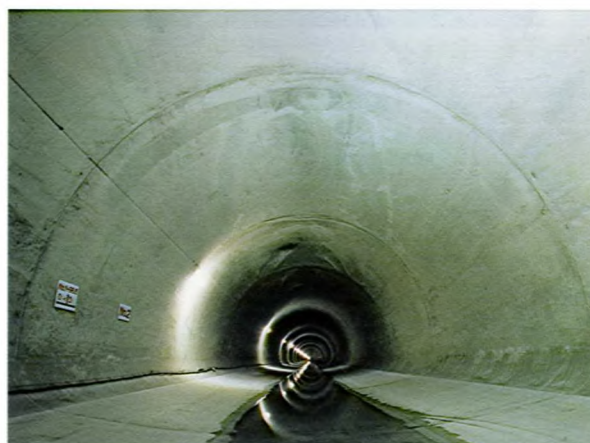
隧道内部完成
