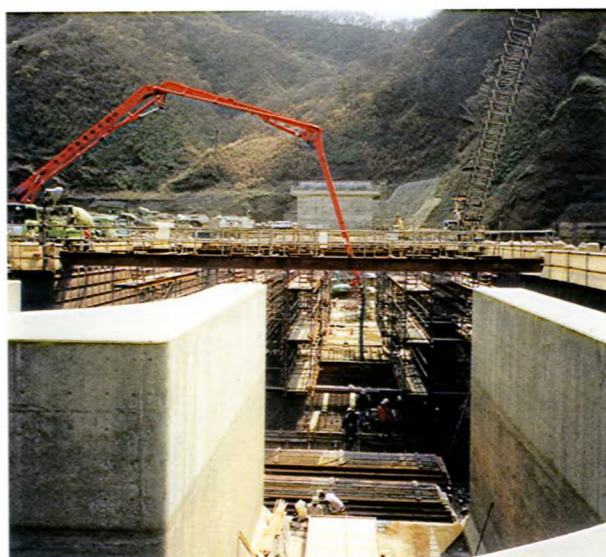
コンクリート打設
