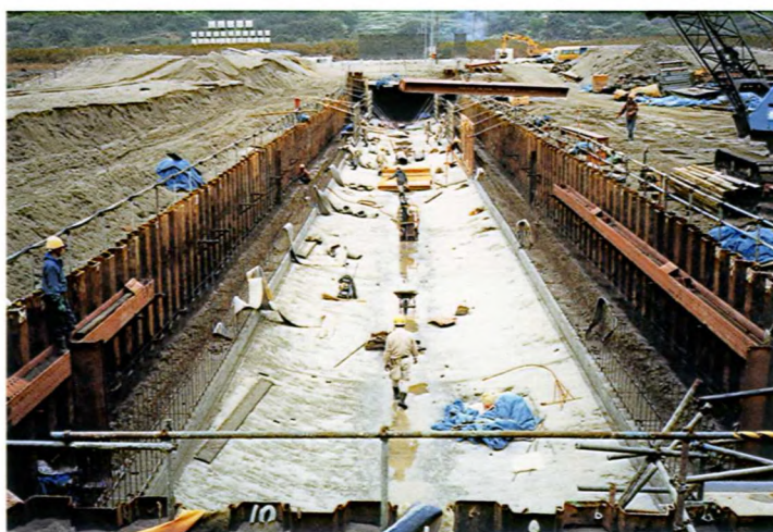
国上隧道河海工：施工状況
