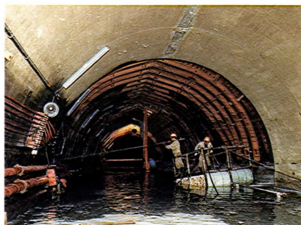
施工状況：出水
