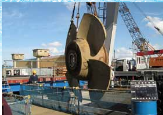
▲古い羽根車(インペラ)の取り外し
