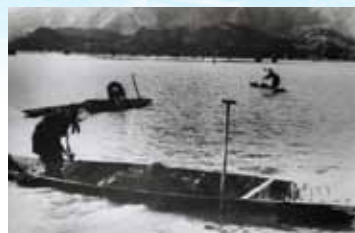
▲田んぼの客土搬入の作業状況
