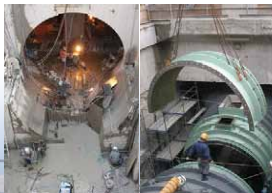
▲主ポンプの更新工事の様子
