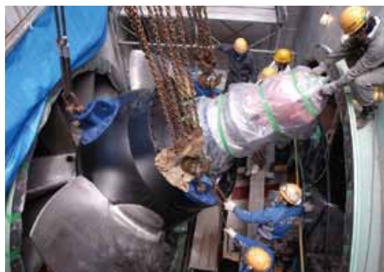
▲新しい羽根車(インペラ)の取り付け
