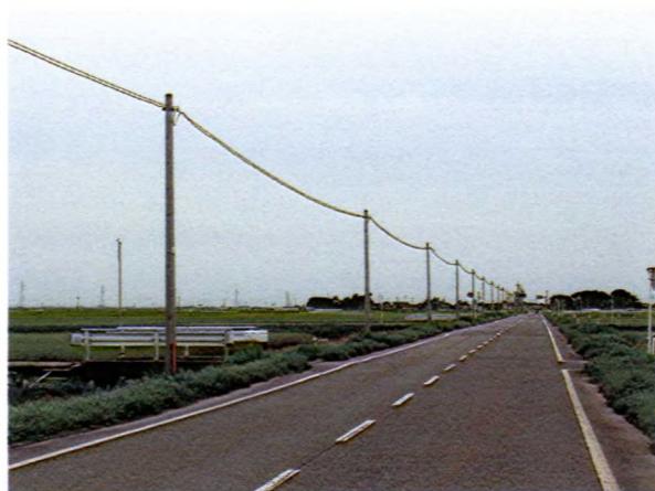
光ケーブル架設状況
