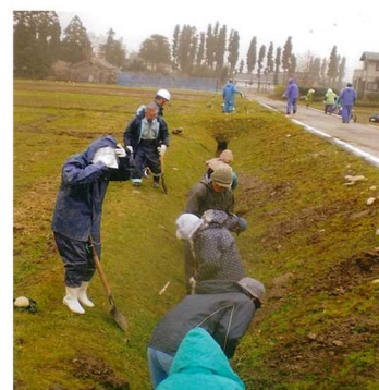
写真 3 用排水路の浚渫
