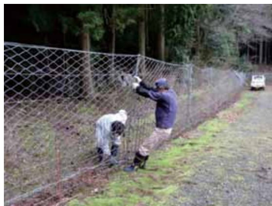
ネットフェンスの点検・補修
