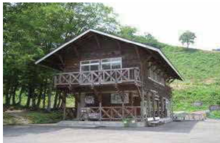
写真3 管理棟「どんぐり庵」
