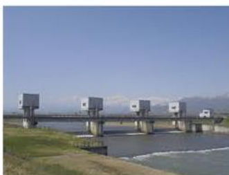
国営関川頭首工 平成7年7月 災害復旧関連で改修
