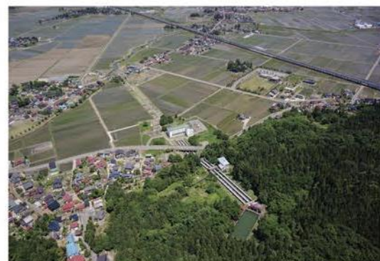
最末端の板倉発電所 東北電力(株) 発電後の用水は、上江、中江用水として利用
