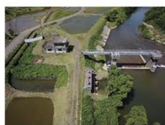
県営 矢代川頭首工(現況)
