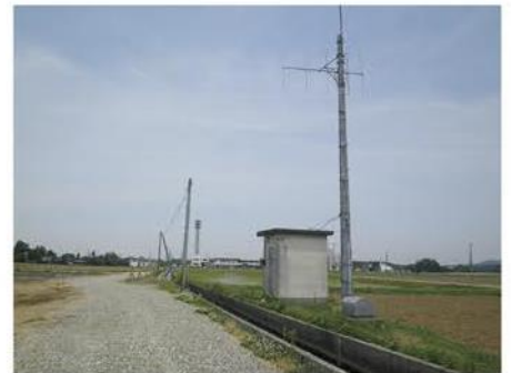
平場系水位観測局(現況)
