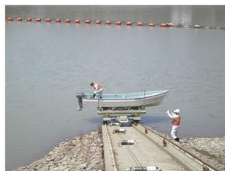
繫船設備の老朽化
