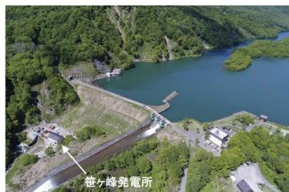
小水力発電所 全景
