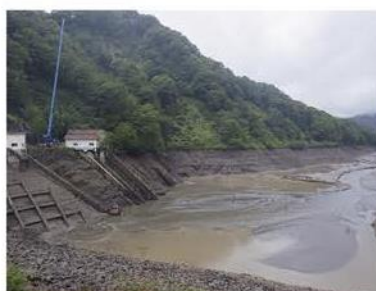
取水・放流ゲート付近
