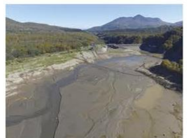
貯水池内の堆砂(真川筋)
