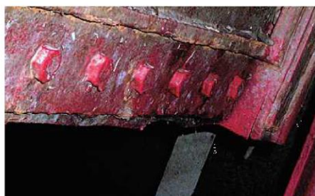
ダム制水ゲートの劣化
