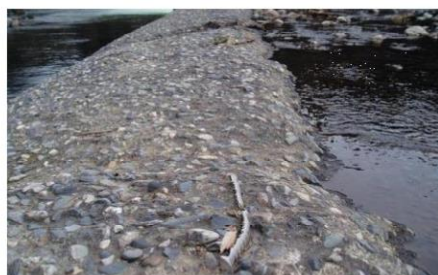
頭首工固定堰のコンクリート摩耗
