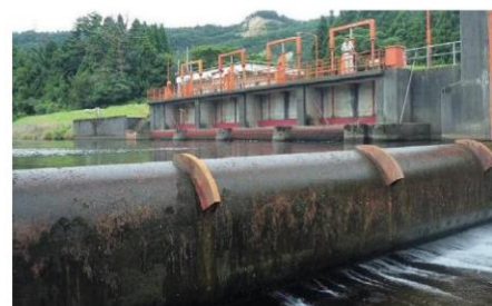
頭首工土砂吐ゲートの劣化
