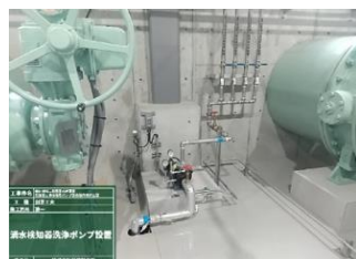
満水検知器洗浄設備（写真1）
