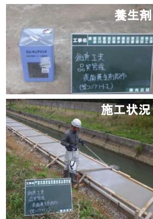
被膜型表面養生剤を用いた品質確保の取組（写真2）
