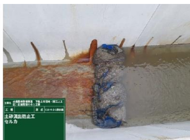
牡蠣貝殻を利用した濁水処理対策（写真2）
