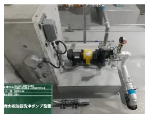
満水検知器洗浄設備（写真1）
