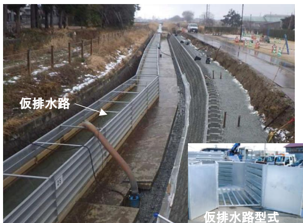
現場に設置した仮排水路（写真1）
