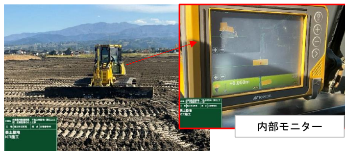
ICT技術の積極的活用（MCブルドーザによる整地） （写真1）
