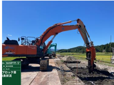
地盤改良工の実施（左側：機器仕様確認、右側：施工状況）（写真1）
