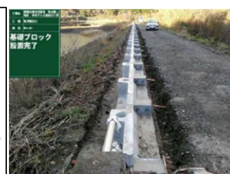
実施中の工夫（防護柵工の基礎変更） （写真1）
