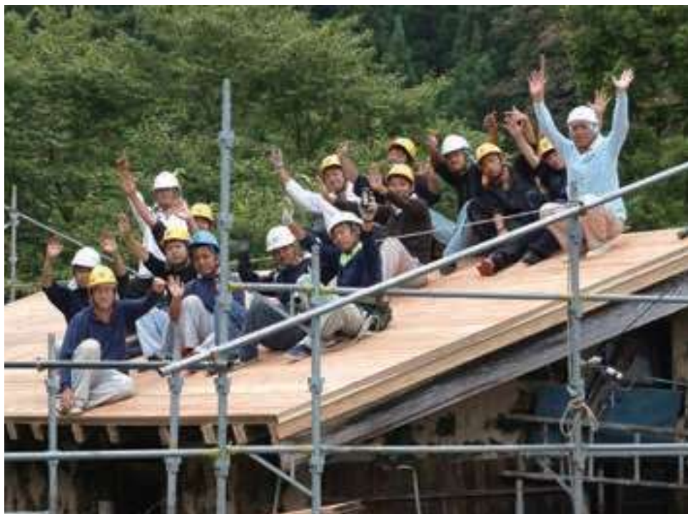
福井工大生による伝統的古民家の修復再生活動
