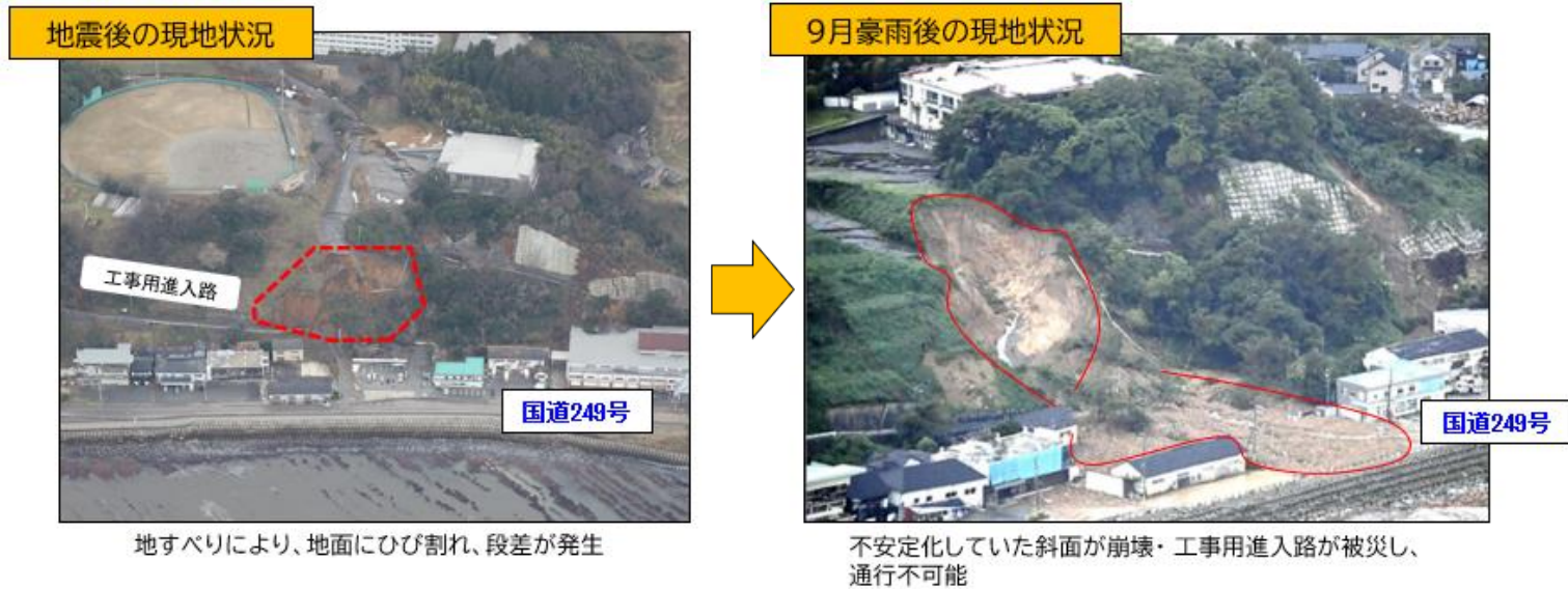
【被災状況（一部区間）】
