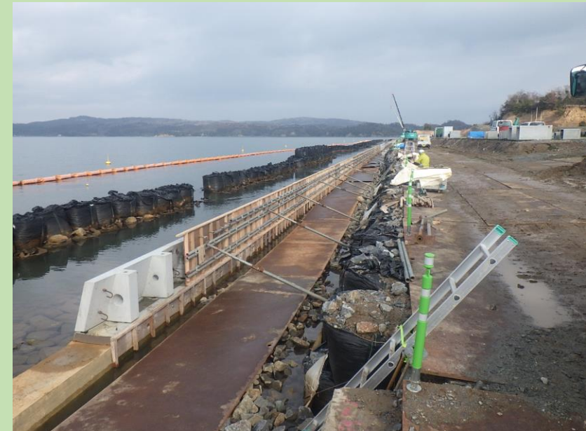
現在の復旧状況 (海岸堤防コンクリート打設) (R8.3)
