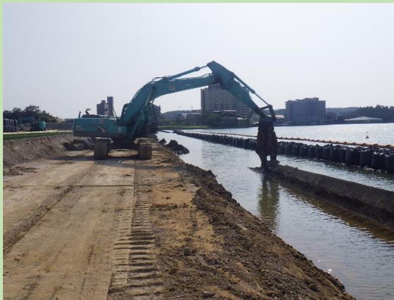
復旧作業状況 (既設海岸堤防撤去) (R7.7)
