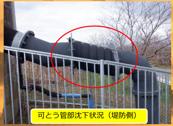
堤防部 橋台周辺の沈下
