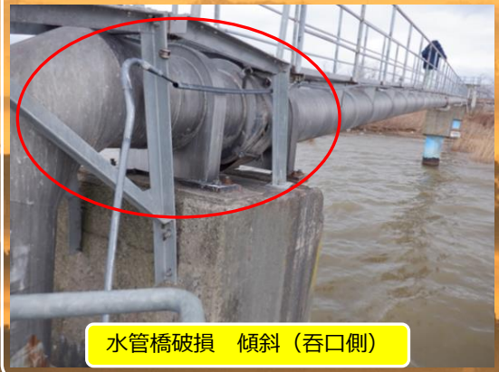
水管橋 橋脚の傾斜
