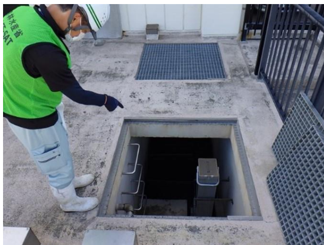
農業集落排水施設の点検(於 輪島市)
