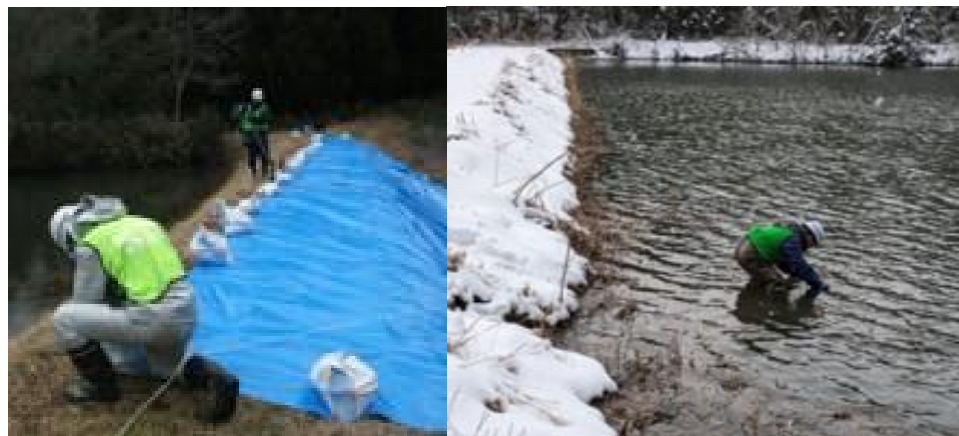
浸食防止対策(ブルーシート設置)及び 水位低下作業(斜樋の開栓)
