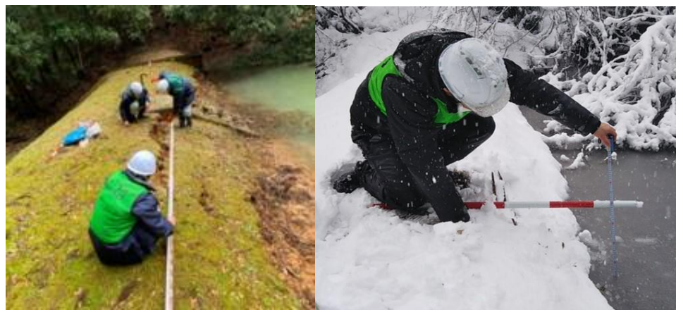
堤体の被害状況把握(亀裂や崩落等)及び貯水位の計測
