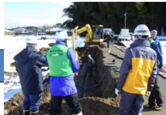
応急復旧作業の監督・立会
