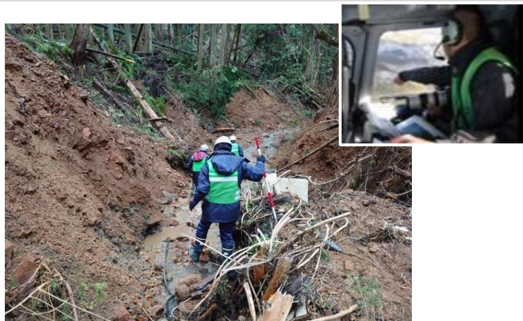
ため池へ徒歩にて進入 進入が困難な場合、ヘリ調査を実施
