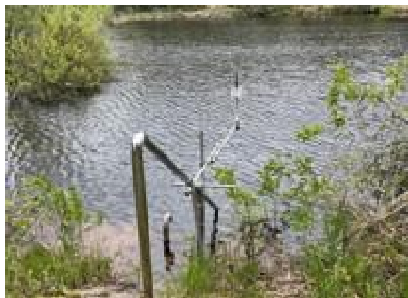
水位計設置による遠隔監視 (早期の水位低下が困難なため池)
