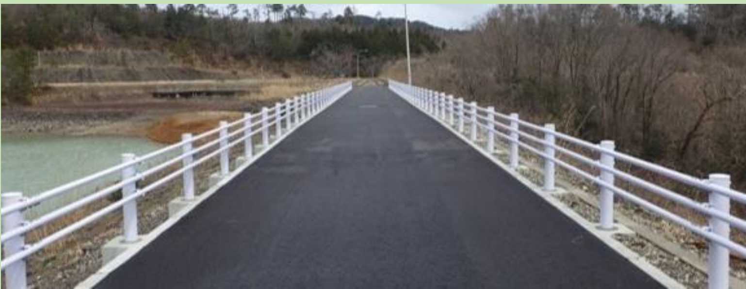
ダム堤体の復旧工事の完成
