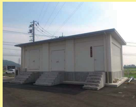
完成した中ノ郷発電所（福井市）
