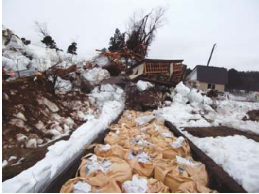
上江幹線水路被災状況（新潟上越）
