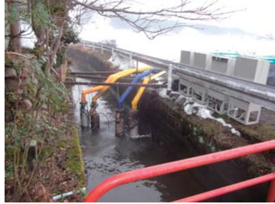
災害応急用ポンプ設置状況（新潟上越）
