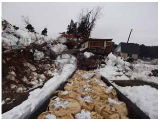
上江幹線水路被災状況（新潟上越）
