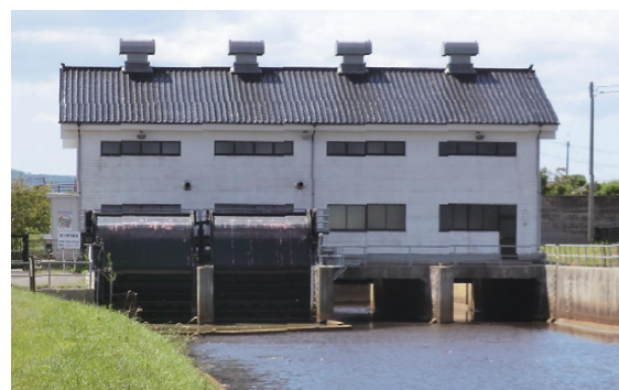
【皆川排水機場】
