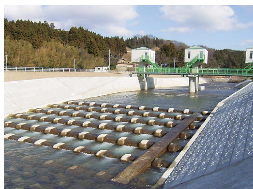
【小倉川頭首工下流側】
