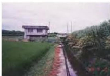
皆川 排水 機場
