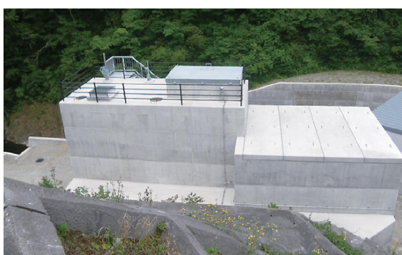
【外山ダム調圧水槽】
