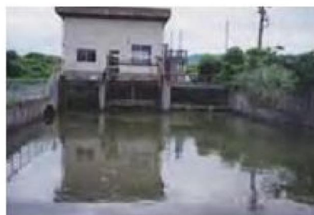
中興 排水 機場
