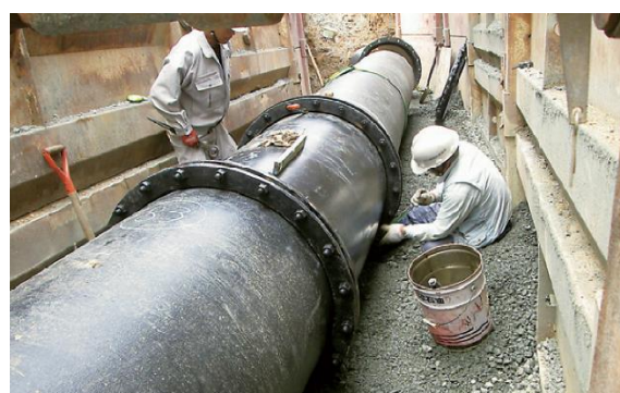
【外山幹線用水路管の設置(工事中)】
