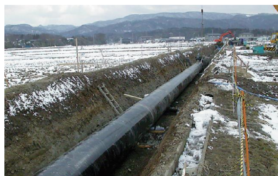
【小倉幹線用水路の管の設置(工事中)】
