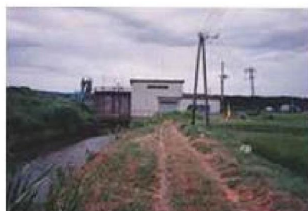
国仲 排水 機場
