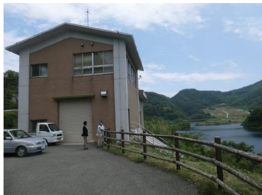
【景観に配慮した小倉ダム管理棟】
