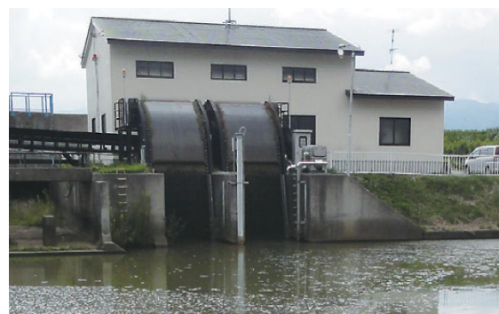
【中興排水機場】
