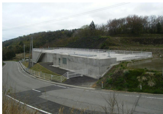
【景観に配慮した外山調整水槽】
