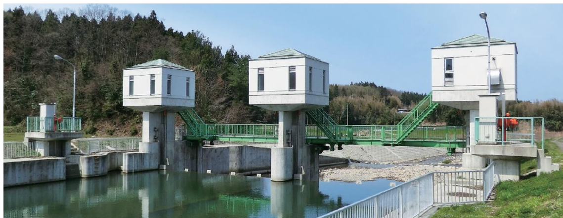
【小倉川頭首工】
