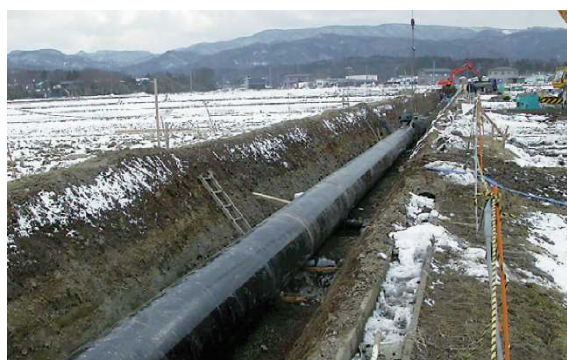
【小倉幹線用水路の管の設置(工事中)】
