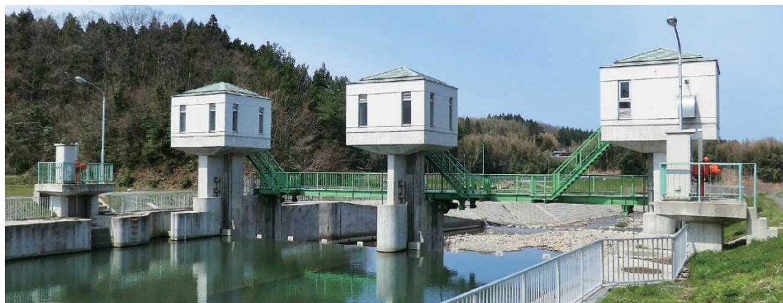
【小倉川頭首工】
