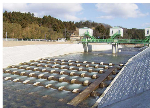
【小倉川頭首工下流側】
