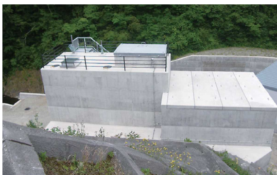
【外山ダム調圧水槽】
