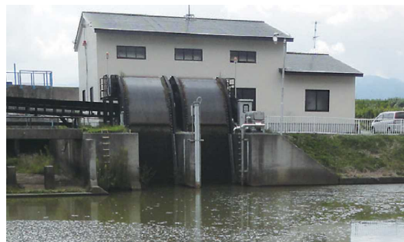
【中興排水機場】
