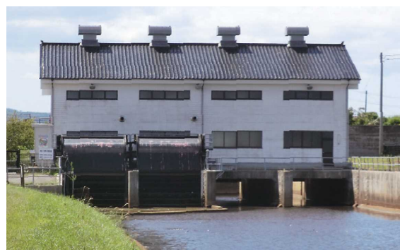
【皆川排水機場】
