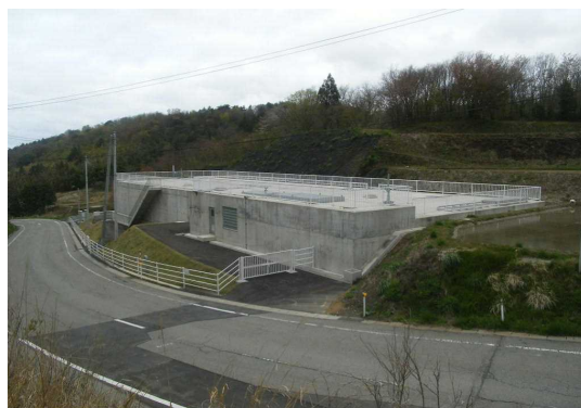
【景観に配慮した外山調整水槽】
