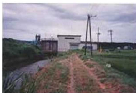
国仲 排水 機場
