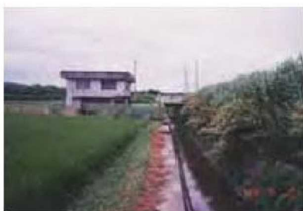
皆川 排水 機場
