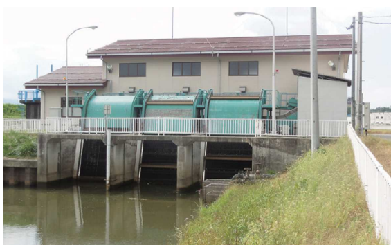
【国仲排水機場】
