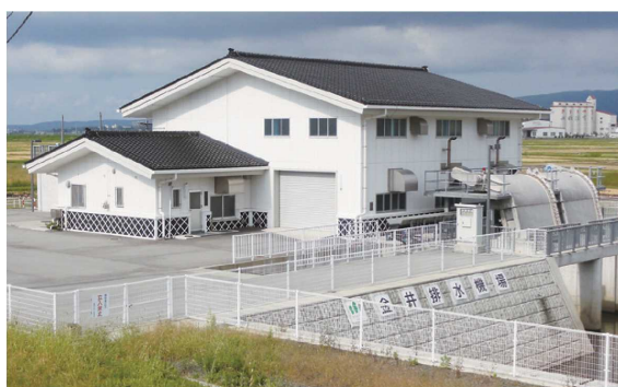
【金井排水機場】
