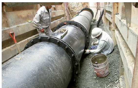
【外山幹線用水路管の設置(工事中)】
