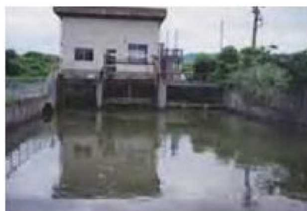
中興 排水 機場
