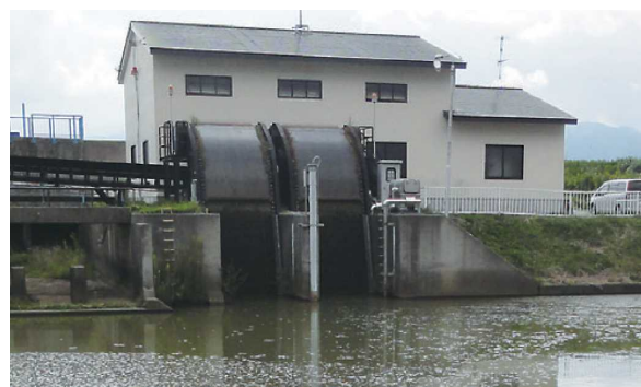
【中興排水機場】
