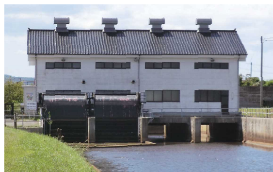
【皆川排水機場】
