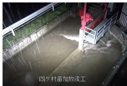
R5 年 7 月豪雨（最大日雨量 176 mm） 新設した余水吐から幹線排水路に流入
