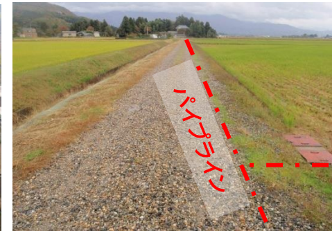
【用水路のパイプライン化】
