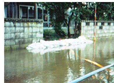
【民家への浸水】
