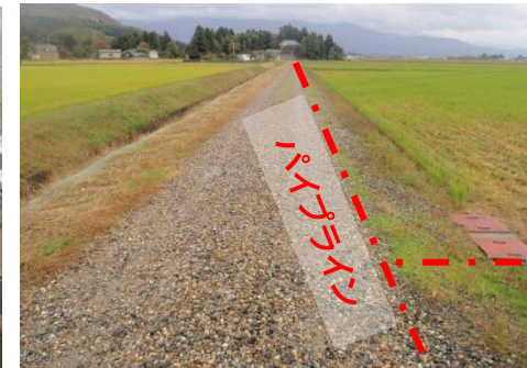
【用水路のパイプライン化】
