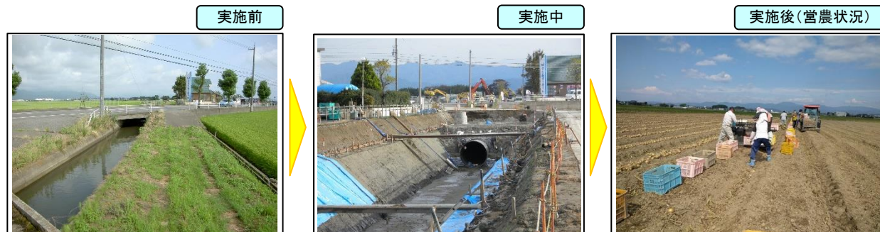
用水路のパイプライン化により、安定的な農業生産構造の確立を図る。
