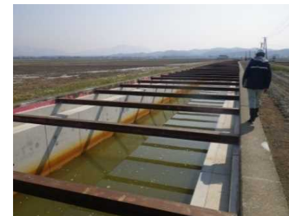
○改修された姥谷内川排水路
