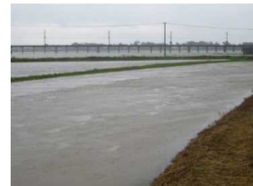
○大雨時の潟川排水路
