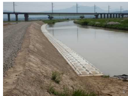
○改修された潟川排水路(右岸)
