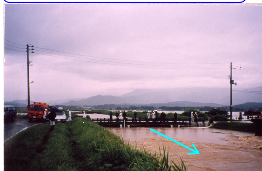
大野地（右岸下流から県道大野地橋を望む）
