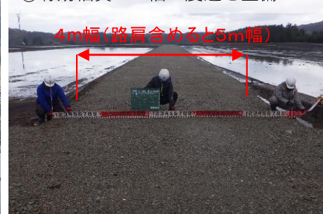
②有効幅員4m幅の農道を整備
