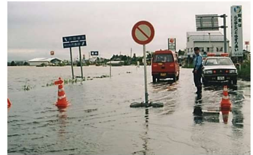
●H10. 8降雨による湛水状況（奥右衛門川排水路）
