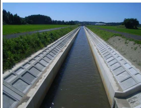
○改修後の五千石川排水路
