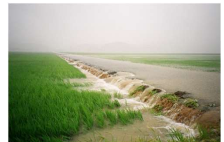
○豪雨時における排水路からの越水状況
