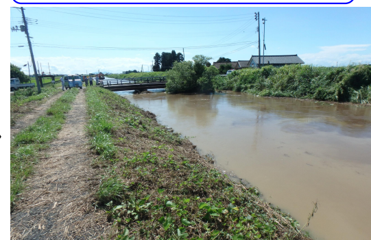
大野地（左岸上流から県道大野地橋を望む）
