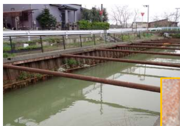
鋼矢板護岸の腐食状況
