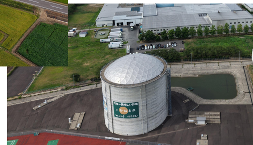
本地域に用水を供給している国営十郷調圧水槽
